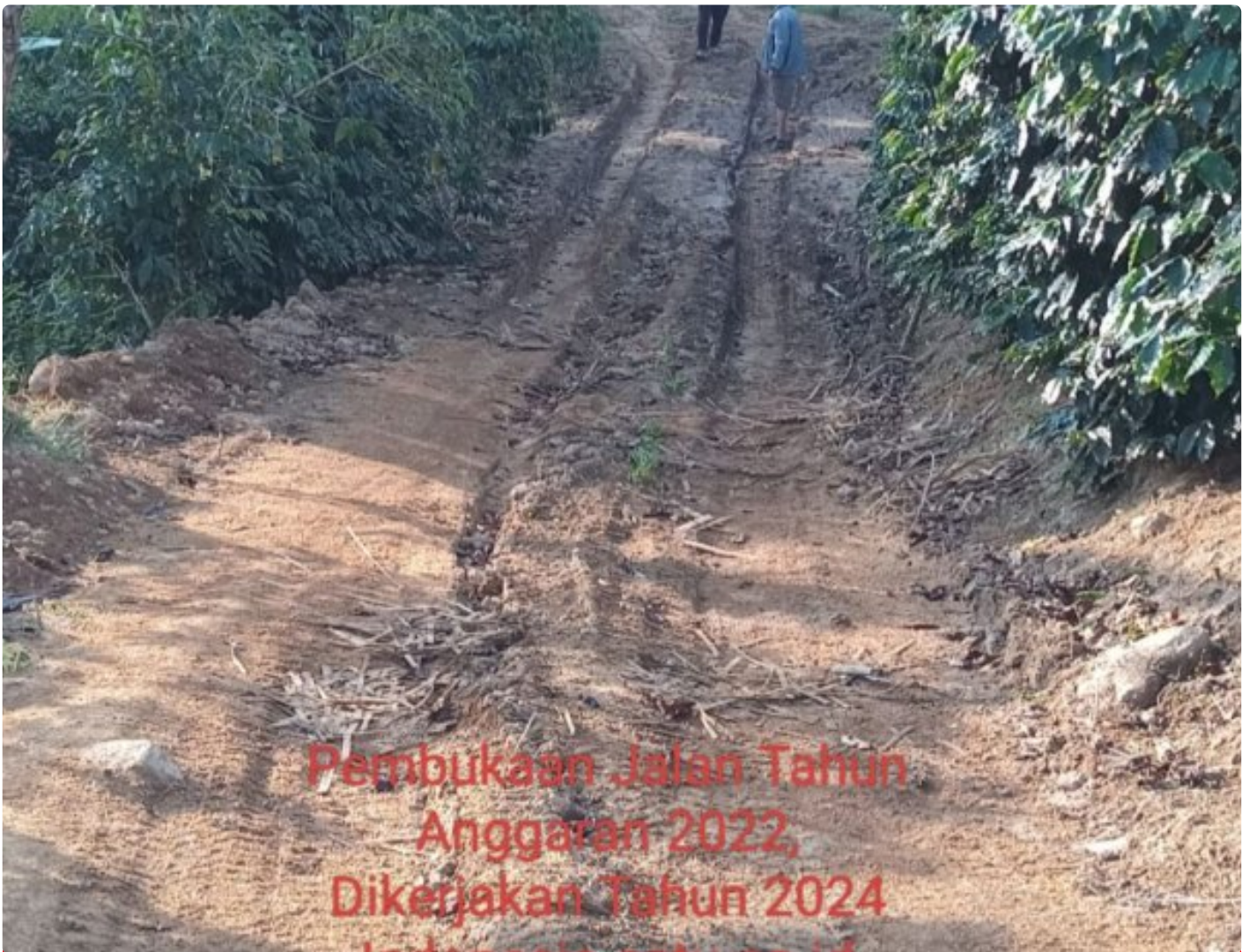
Proyek Pembukaan Jalan Tahun 2022, Dikerjakan Tahun 2024
